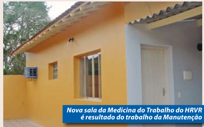
Integrante da equipe de manutenção executa melhorias com EPIs em ordem
